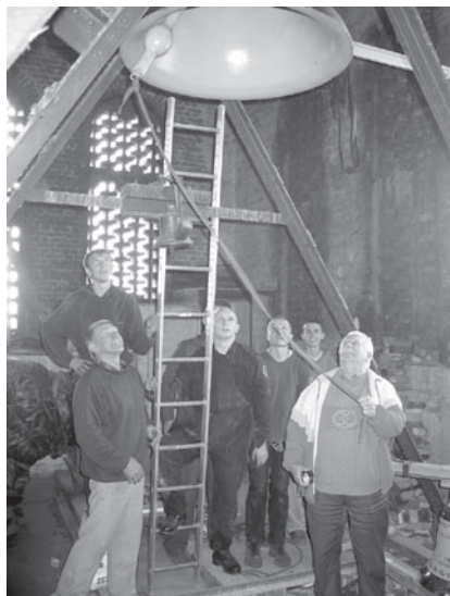
Przy montażu dzwonów
