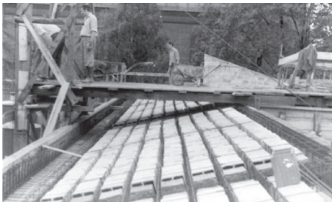
Całość stropu została zabetonowana w sierpniu
